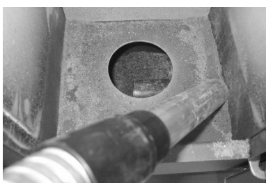
Fig. 31 - Reinigung Fach Aschenkasten
